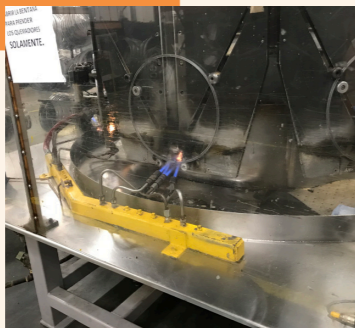
アルミチャンネルの溶接
