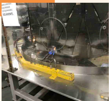
アルミチャンネルの溶接
