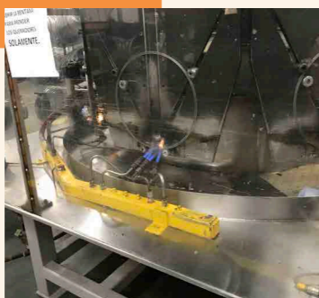
アルミチャンネルの溶接
